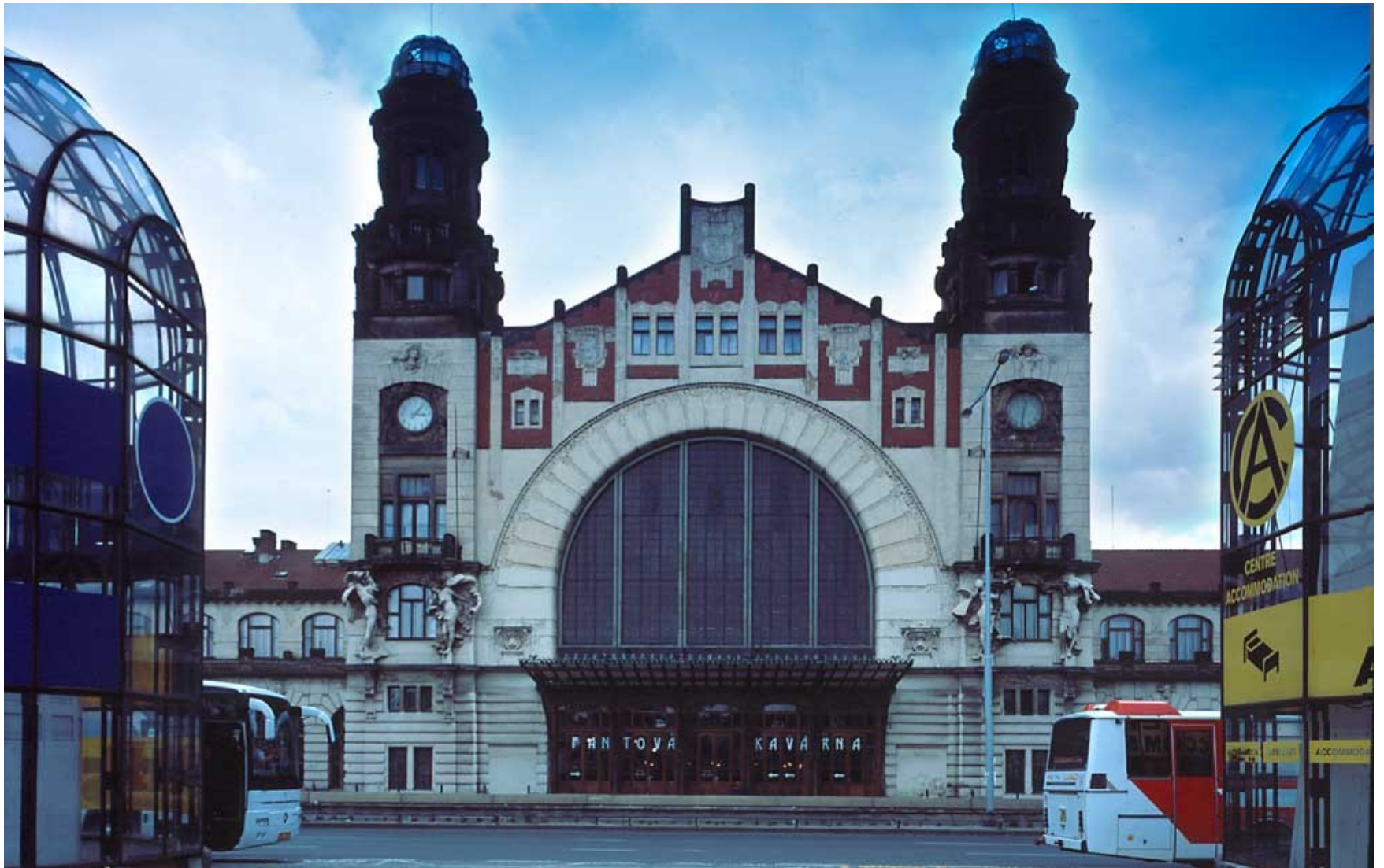
Budova Hlavního nádraží v Praze
