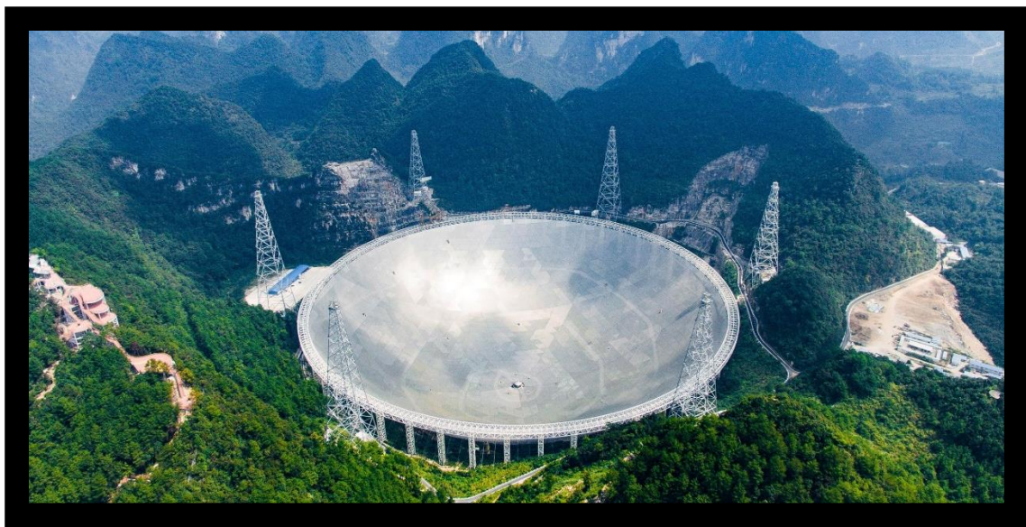
Obrázek 8: Nepohyblivý radioteleskop FAST (Čína) průměr 500m. 7
