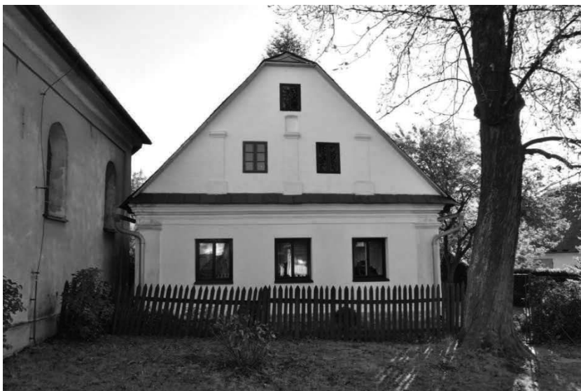
Lipina, zděný dům východosudetského typu
