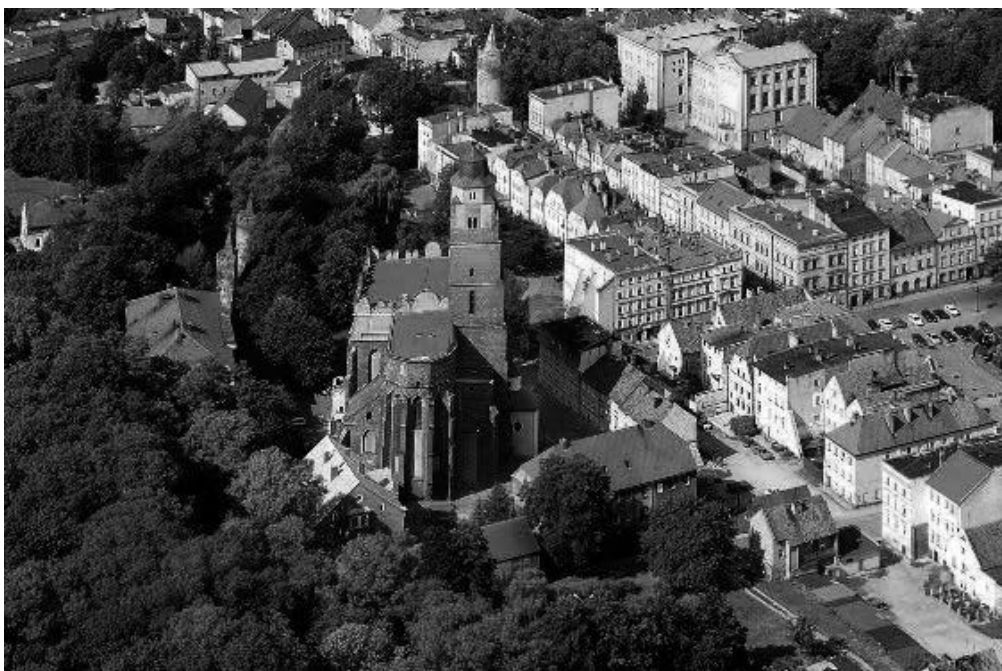
Pačkov, kostel sv. Jana Evangelisty, hradby s obrannými věžemi (vlevo)
