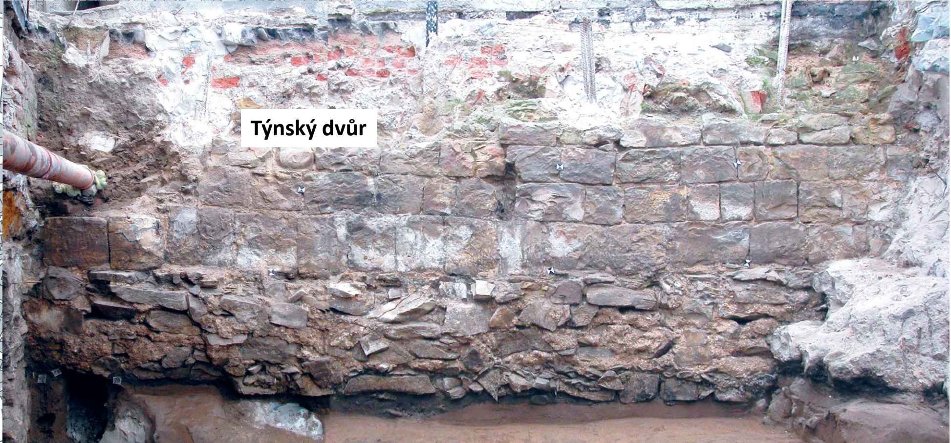
Praha 1-Staré Město, Týnská ulička čp. 1064/I, nadzemní a základová partie kvádřkové zdi.
