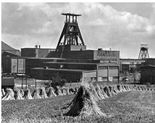
Důl Heřmanice v Ostravě s dvojitou vzpěrovou konstrukcí těžní věže
