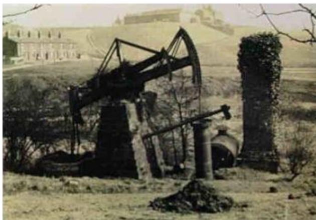
Newcomenův parní stroj z Fairbottom Bobs v anglickém Lancashire, považovaný za nejstarší dochovaný stroj tohoto typu
