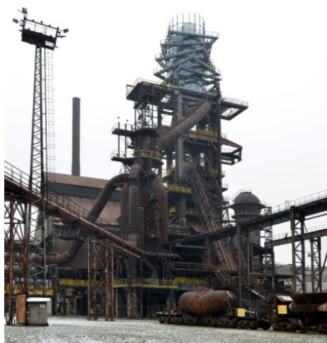
Pohled na bývalou vysokou pec č. 1 v Ostravě-Vítkovicích
