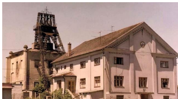
Důl Simson ve Zbýšově – příhradová těžní věž z roku 1902 nad původní zděnou věží typu Malakov
