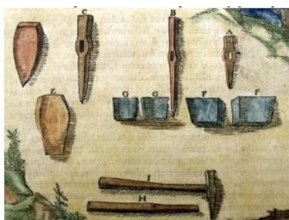
Obr. 4 Nástroje rozrušovací – neboli želízka a klíny, kterými se hornina rozrušuje. Želízko A, zasekáček B, želízko žumpové C, skalní klín D, klín E, hrubý klín F, plechový klín G, dřevěná rukojeť H, v želízku zasazená rukojeť I (Agricola, 2001)
