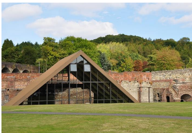
Zastřešení korpusu železářské pece Darbyů v Muzeu železa v Coalbrookdale /UK/
