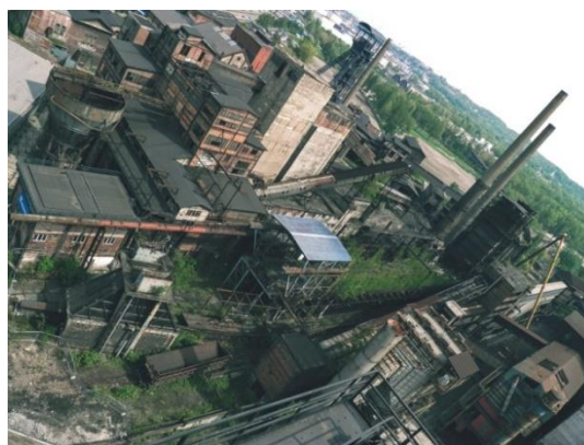
Pohled na bývalou koksovnu a jámu Hlubi- na v DOV
