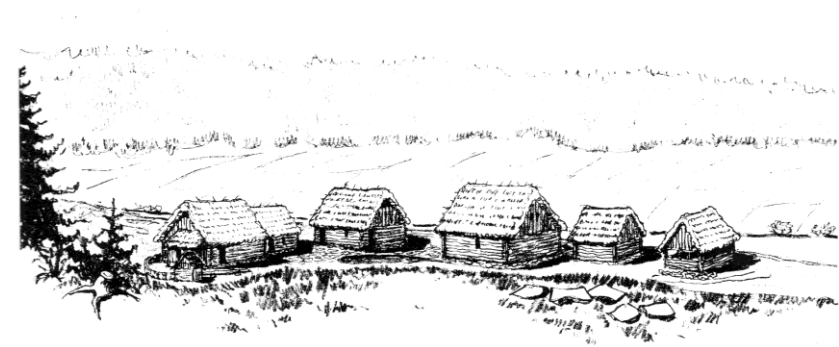
Pohled od jihu.
