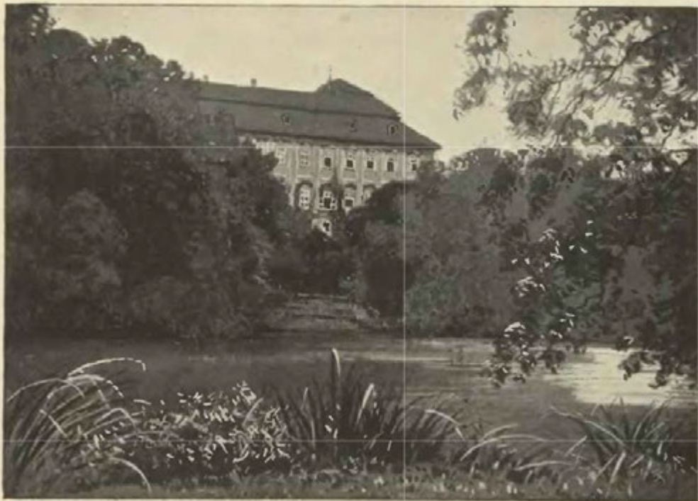
Červený Hrádek od jihu.
