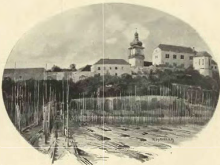
Nový hrad před přestavbou zámecké věže.
