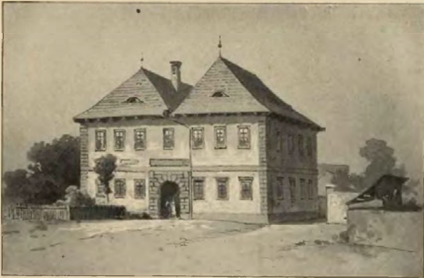
Bývalá tvrz v Žihli.
