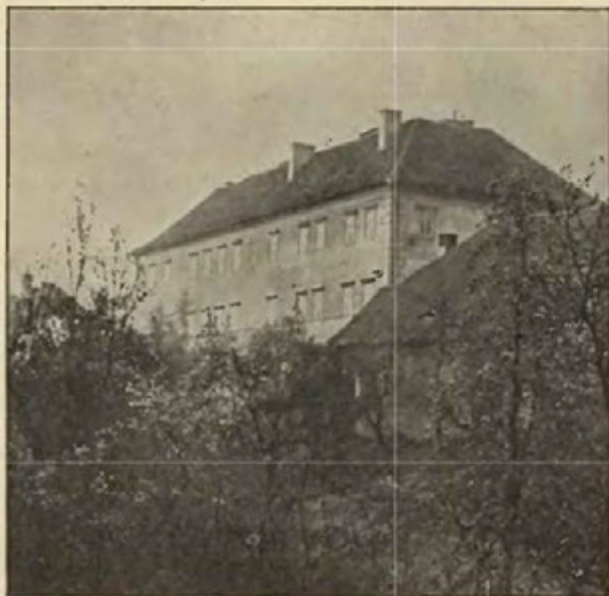
Zámek v Lovosicích od severozápadu.
