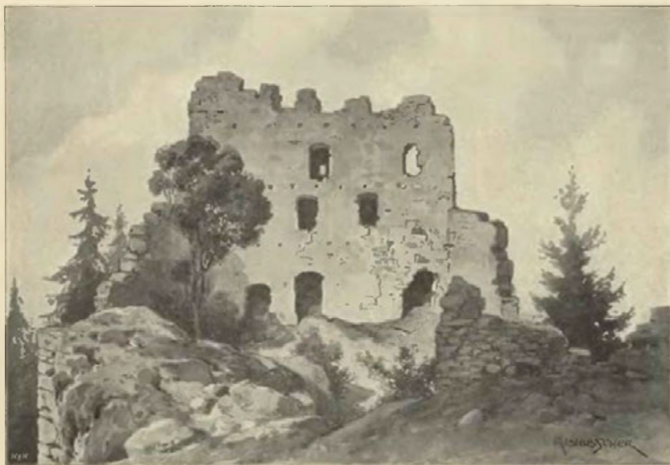
Egrberk, východní strana paláce.
