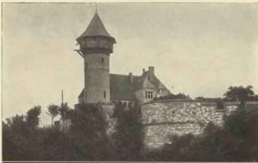
Nynější stavení na Mostském hradšti.
