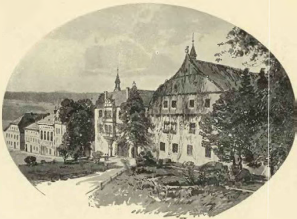
Dolní (Klárovský) zámek v Benešově nad Ploučnicí.
