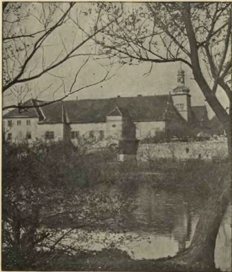
Zámek ve Vršovících u Loun od východu.
