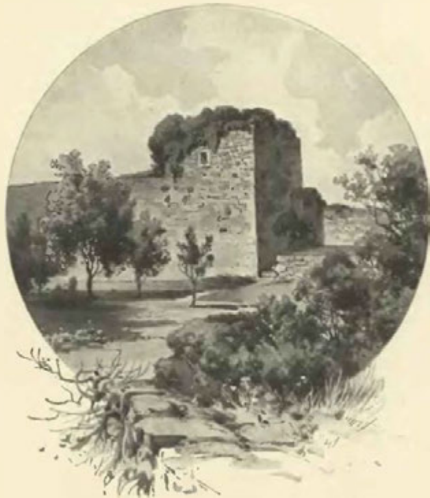
Zbytky bašty a hradeb v Mostě.
