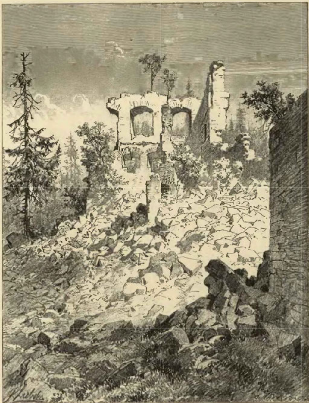
Palác na Menšteině. (Pohled na plánu č. 21.—23.)
