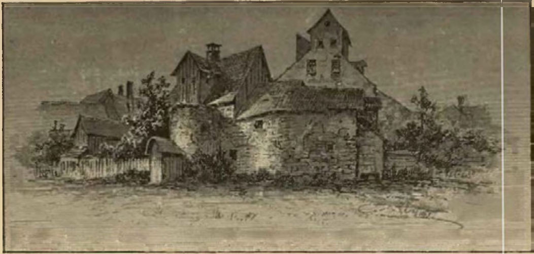
Zbytky bašt v Náchodě („u porážky“).
