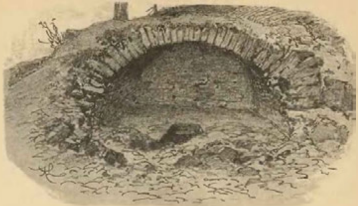
Otvor do sklepení na Ryzemburce.
