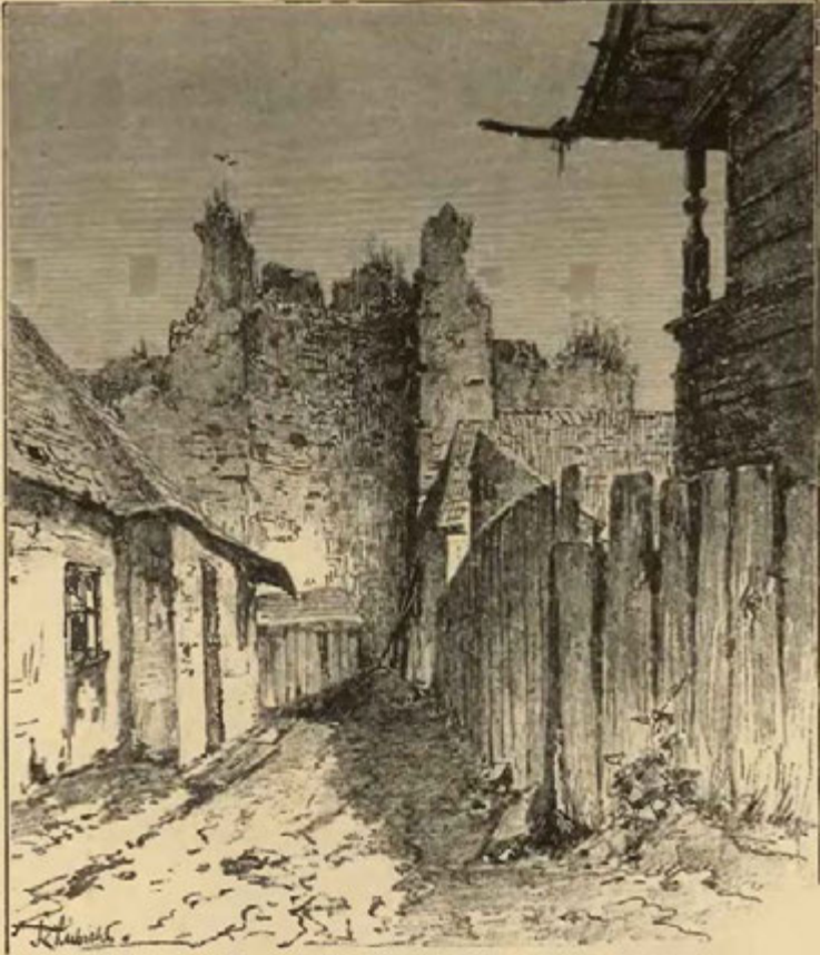
Z opevnění města Náchoda. Pohled na baštu z vnitřní strany.
