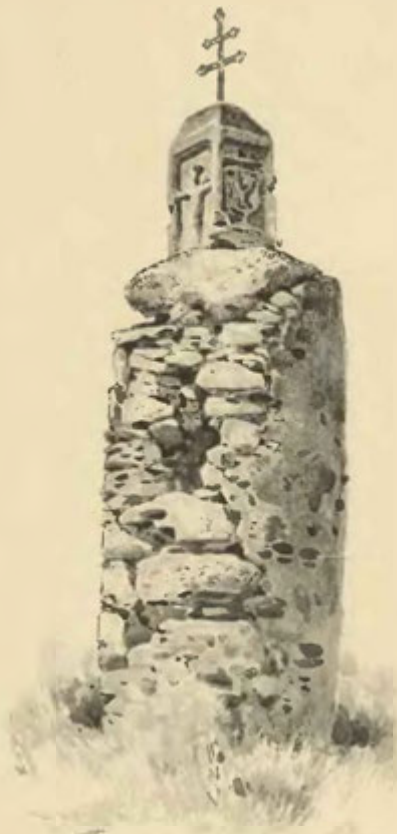
Boží muka pod Týncem při cestě na Klenový. Pohled ze strany západní.
