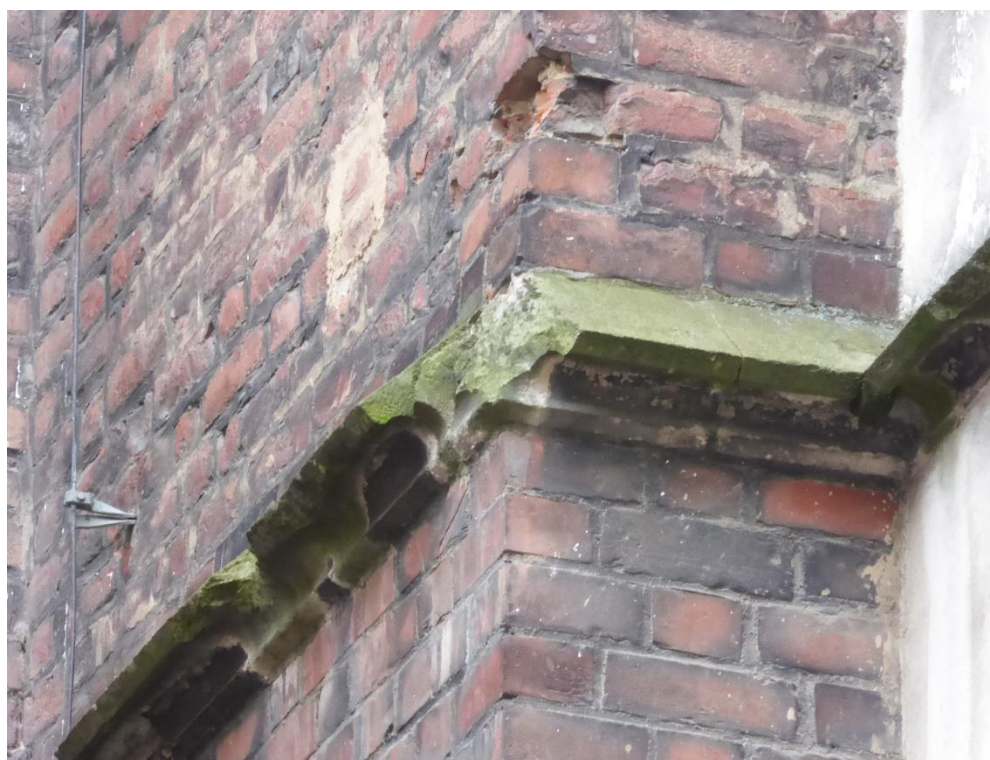
Obrázek 51. Kombinace biologické a fyzikální koroze na pískovcové římsě severního průčelí (foto David Witoš 2019).
