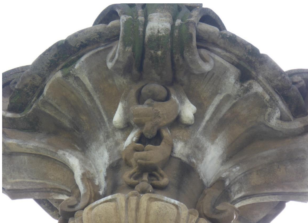
Obrázek 60. Dekoratívni vrcholová váza na štítu západního průčelí pokrytá bílou krustou (foto David Witoš 2019).
