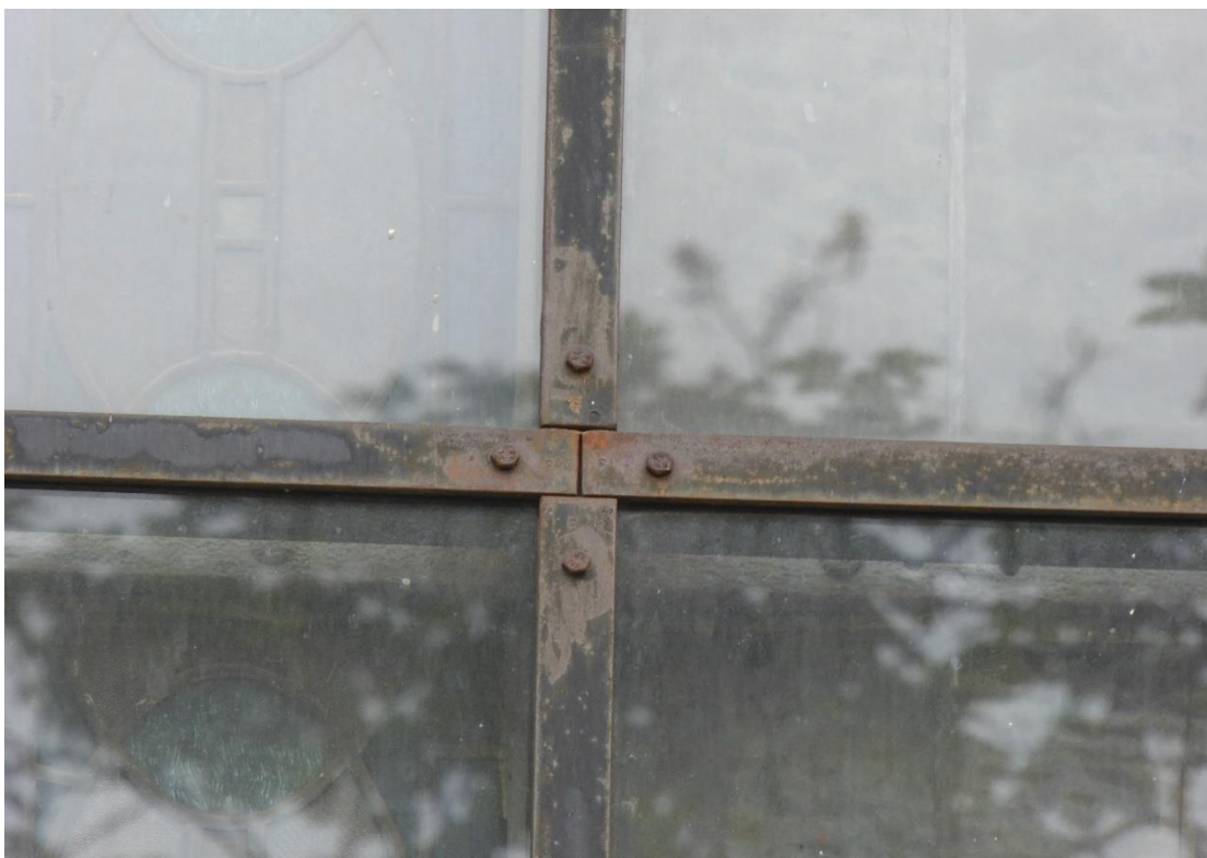
Obrázek 70. Detail koroze okenních výplní (foto David Witoš 2019).
