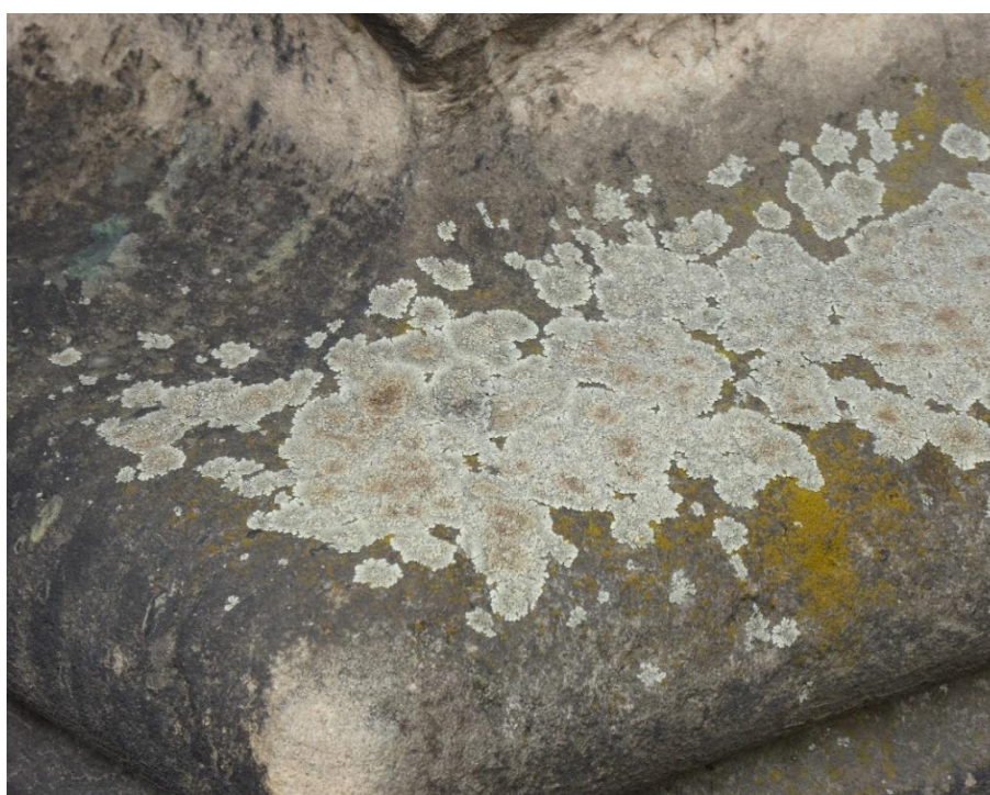
Obrázek 41. Biologické napadení profilované pískovcové soklové římsy na jižním nároží kaple sv. Anny lišejníkem (foto David Witoš 2019).
