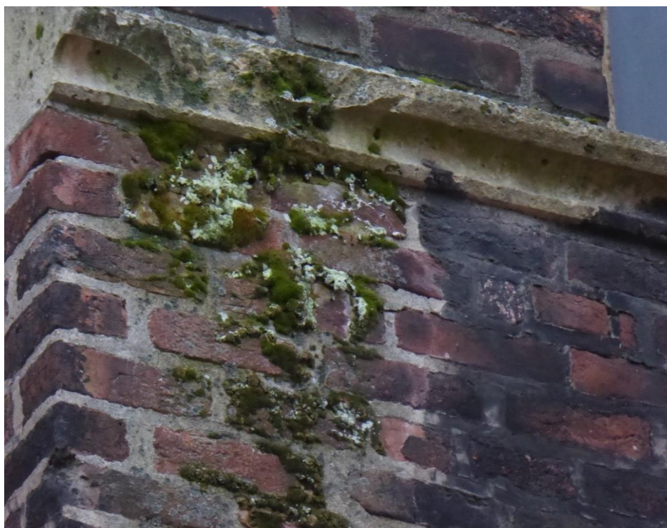
Obrázek 43. Napadení kamenných a cihelných prvků pláště na severním opěráku mechem (foto David Witoš 2019).
