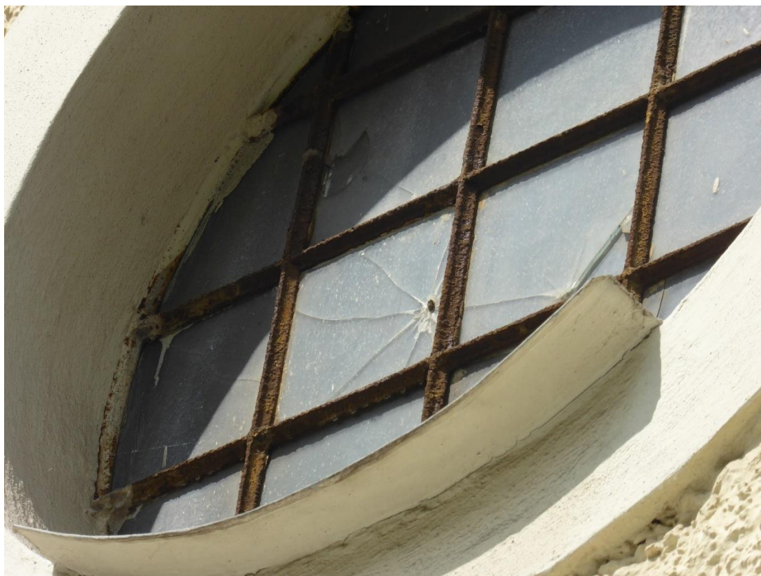
Obrázek 70. Detail koroze okenních výplní (foto David Witoš 2019).
