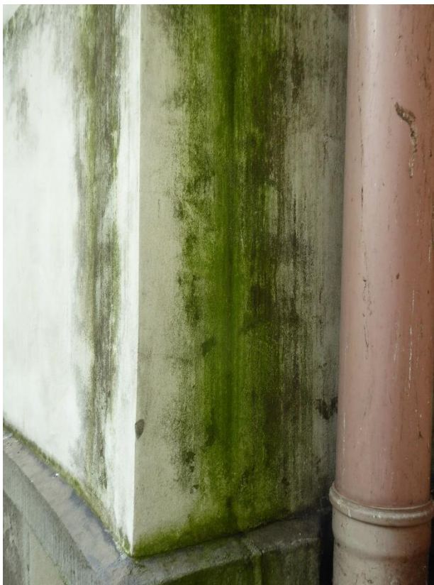
Obrázek 65. Biologické napadení jižní stěny povlakem řas (foto David Witoš 2019).
