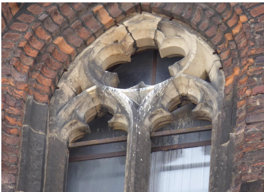
Obrázek 38. Poškození pískovcových kružeb neogotického okna severní věže černou krustou a zčásti ptačím trusem (foto David Witoš 2019).
