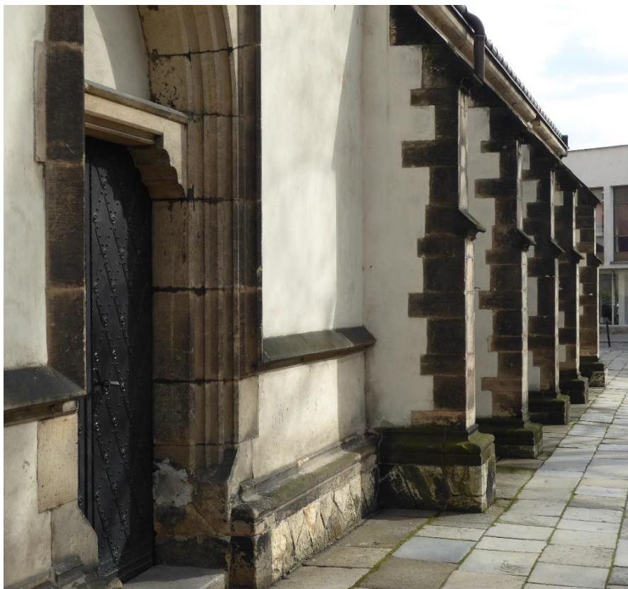
Obrázek 41. Biologické napadení profilované pískovcové soklové římsy na jižním nároží kaple sv. Anny lišejníkem (foto David Witoš 2019).
