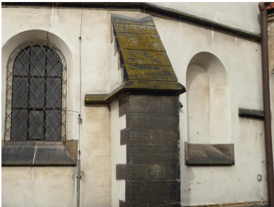
Obrázek 43. Napadení kamenných a cihelných prvků pláště na severním opěráku mechem (foto David Witoš 2019).
