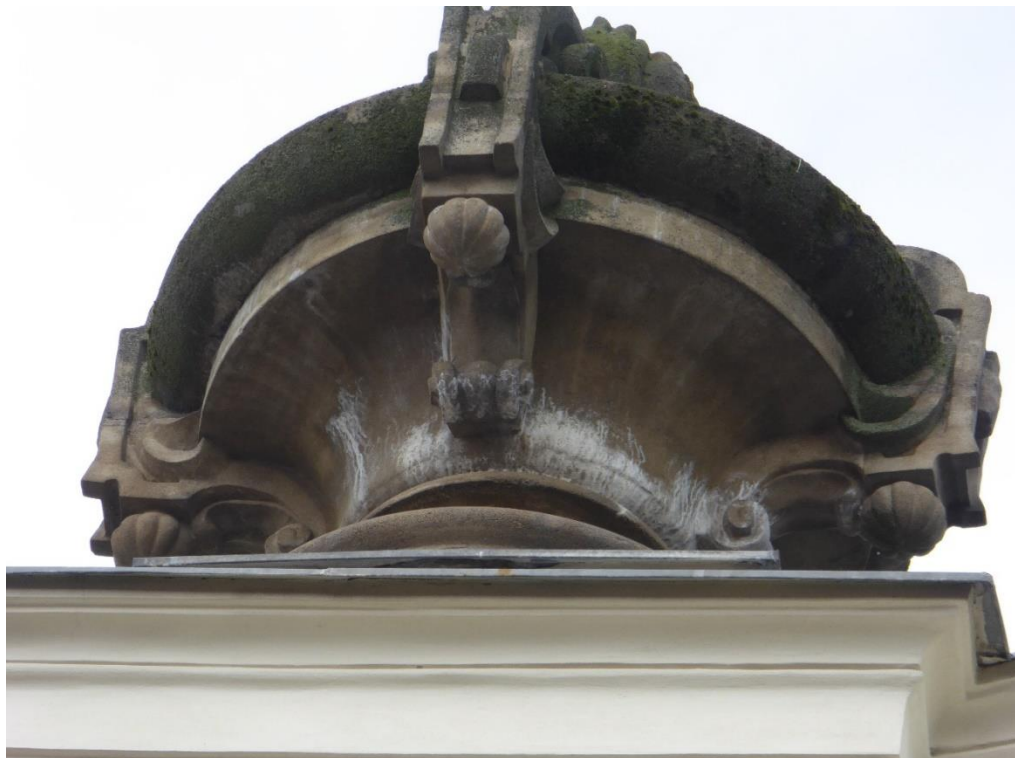
Obrázek 60. Dekoratívni vrcholová váza na štítu západního průčelí pokrytá bílou krustou (foto David Witoš 2019).
