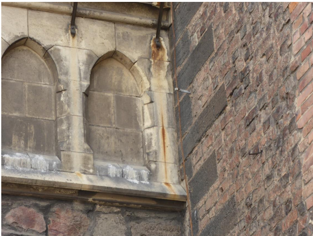
Obrázek 38. Poškození pískovcových kružeb neogotického okna severní věže černou krustou a zčásti ptačím trusem (foto David Witoš 2019).
