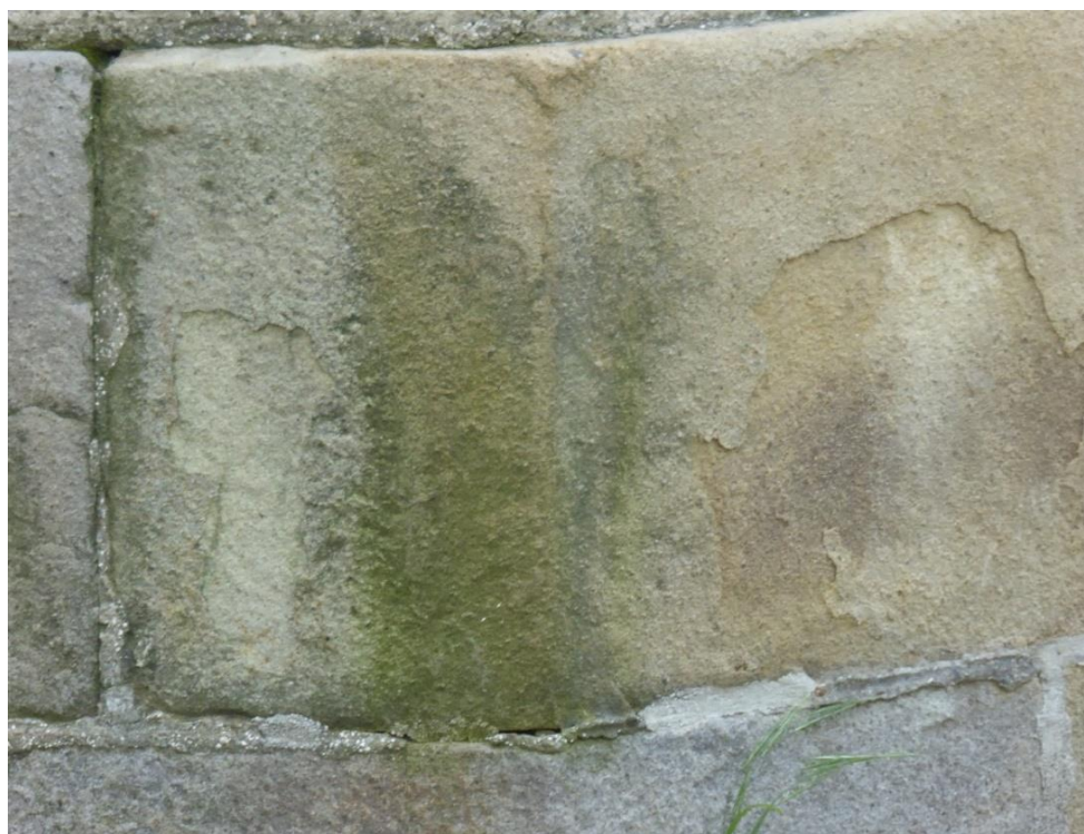
Obrázek 56. Biologické napadení pískovcového soklu řasami (foto David Witoš 2019).
