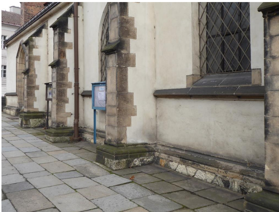
Obrázek 48. Zelený povlak řas na opěrácích bočních kaplí sv. Anny, sakristie a kaple Panny Marie Lurdské (foto David Witoš 2019).
