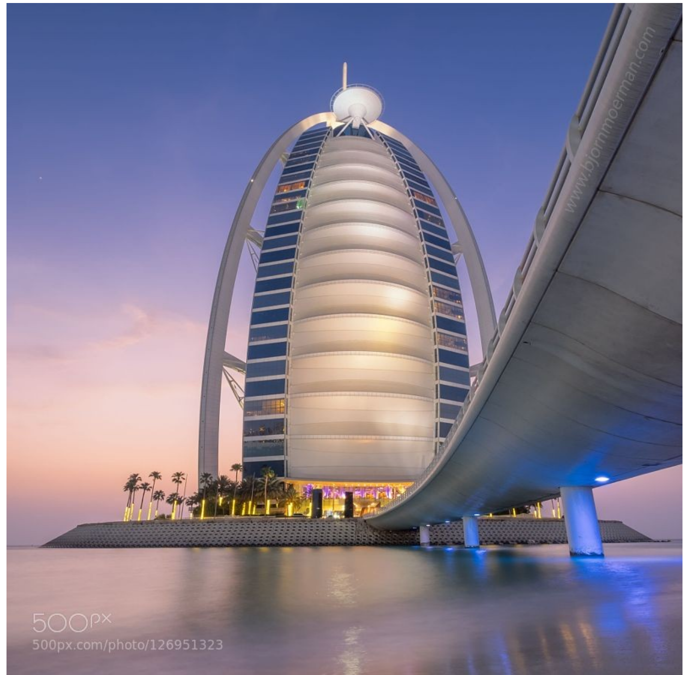
Most spojující hotel s pevninou, který je určen pro pěší i motorová vozidla
