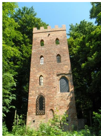
Rytířská bašta ve Wodzisławiu Śl. (před rekonstrukcí)
