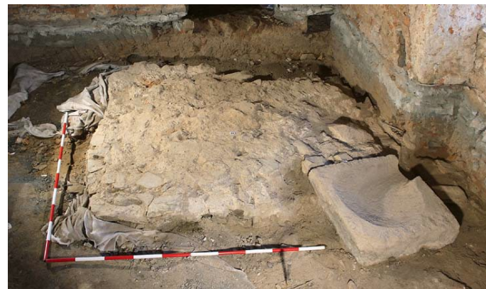
Základ pilíře dymníkového komínu.
