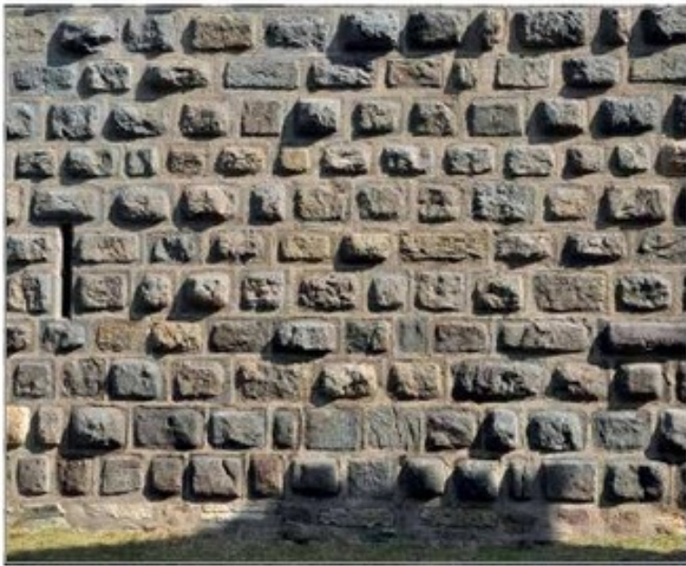
Obr. 3) Hrad Zvíkov, Hlízová věž. Spodní část západního průčelí (foto J. Varhaník 2011).
