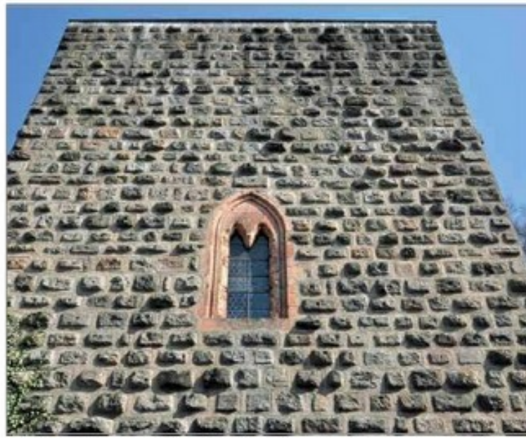
Obr. 4) Hrad Zvíkov, Hlízová věž, horní část západního průčelí (foto J. Varhaník 2011).
