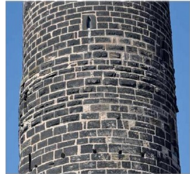
Obr. 12) Hrad Jenštejn, střední část věže s bosovanými kvádry (foto J. Varhaník 2014).
