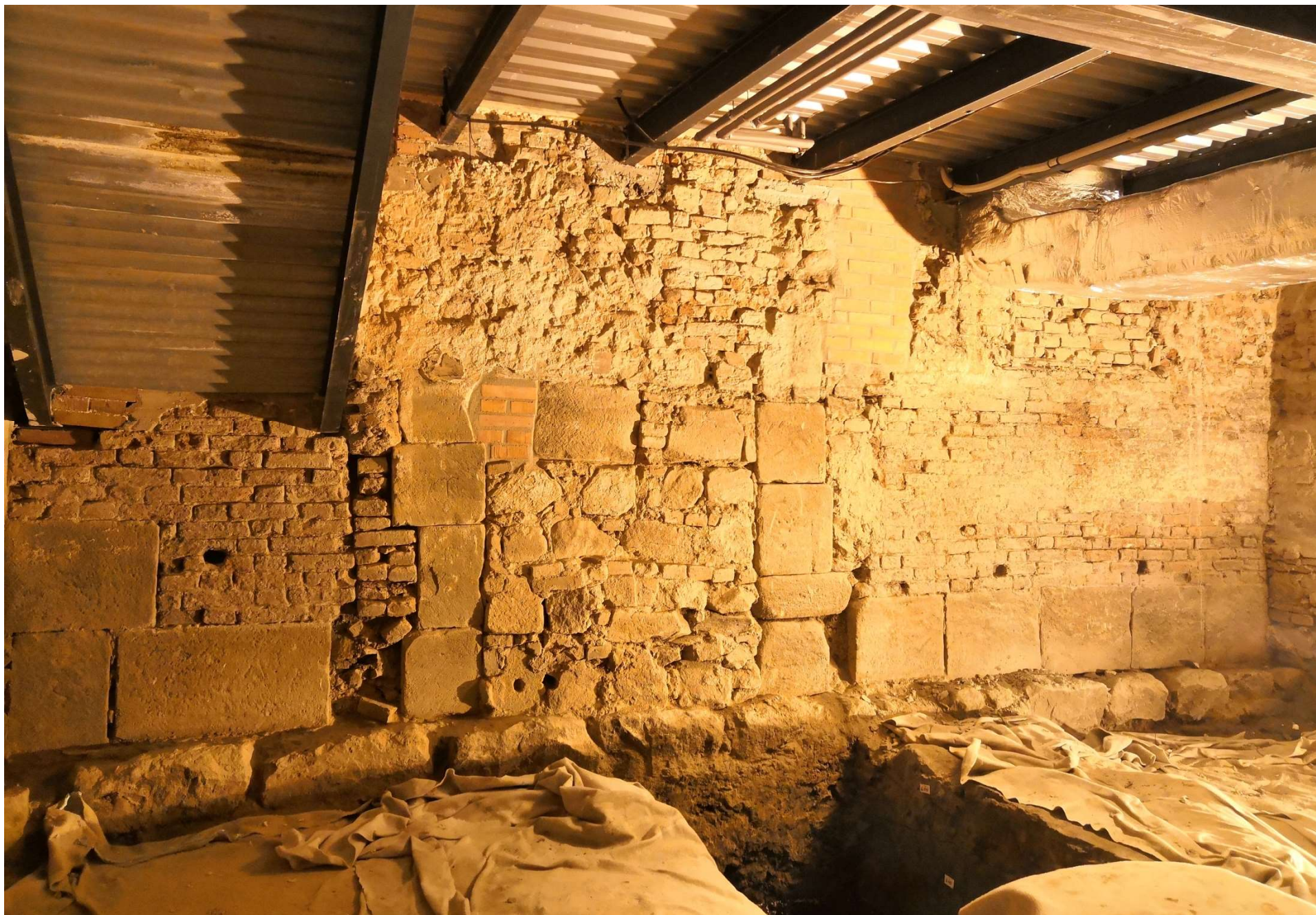
ZAV 2018-2020 – barokní kvadratura – torzo vstupu do středověké „černé“ kuchyně, na druhé straně je jižní část křížové chodby
