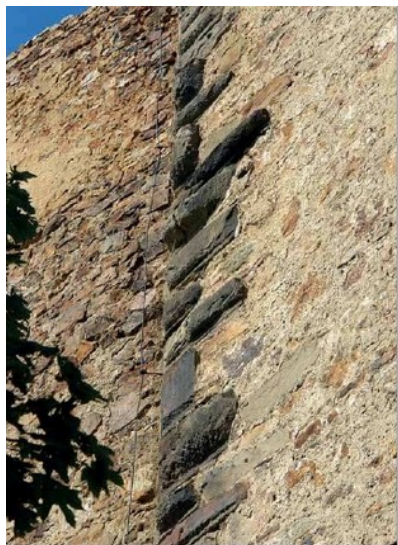
Obr. 10) Hrad Točnick, jihovýchodní nároží královského paláce s armaturou z bosovaných kvádrů (foto J. Varhaník 2010).
