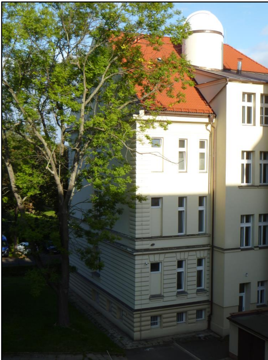
Obrázek 2: Kopule observatoře směrem od dvora budovy.
