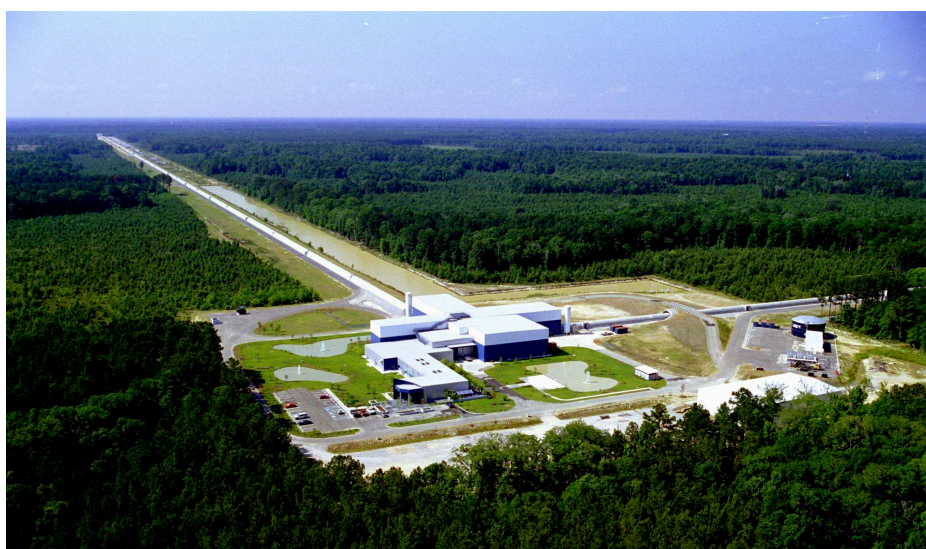
Obr. 9. Sesterský interferometr LIGO v Livingstonu (stát Louisiana). Je vzdálen 3000 km od stanice LIGO v Hanfordu, obě zařízení fungují v koincidenčním režimu jako jeden detektor. Zdroj: Caltech/MIT/LIGO Laboratory.
