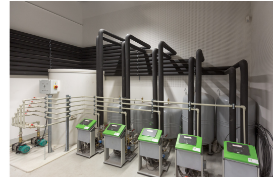
OxyReduct – protipožární opatření
