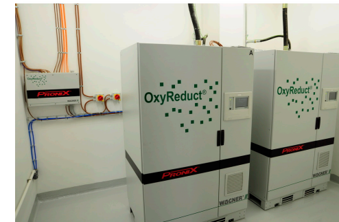
OxyReduct – protipožární opatření
