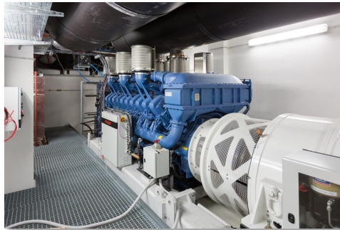
Záložní zdroje energie UPS 2x2,5MVA
