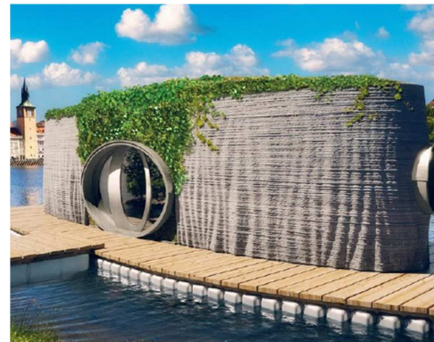
- Plovoucí český dům Prvok z tisknutého betonu
