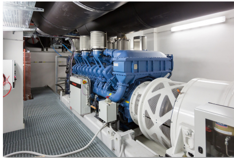
Záložní zdroje energie UPS 2x2,5MVA
