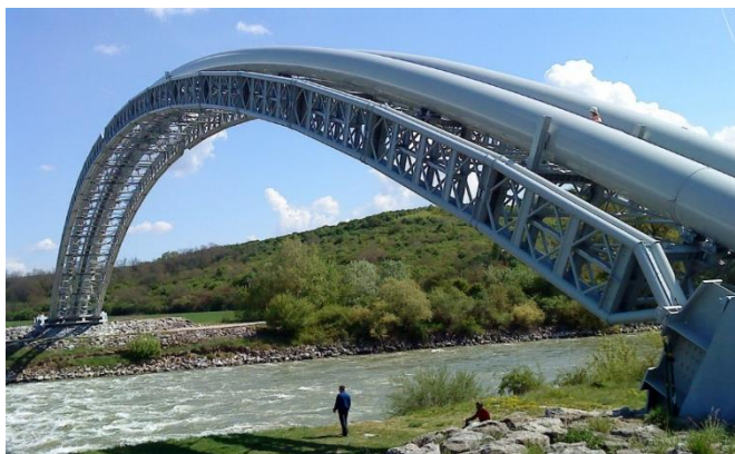
Obrázek 16: Plynovod nad řekou Váh
