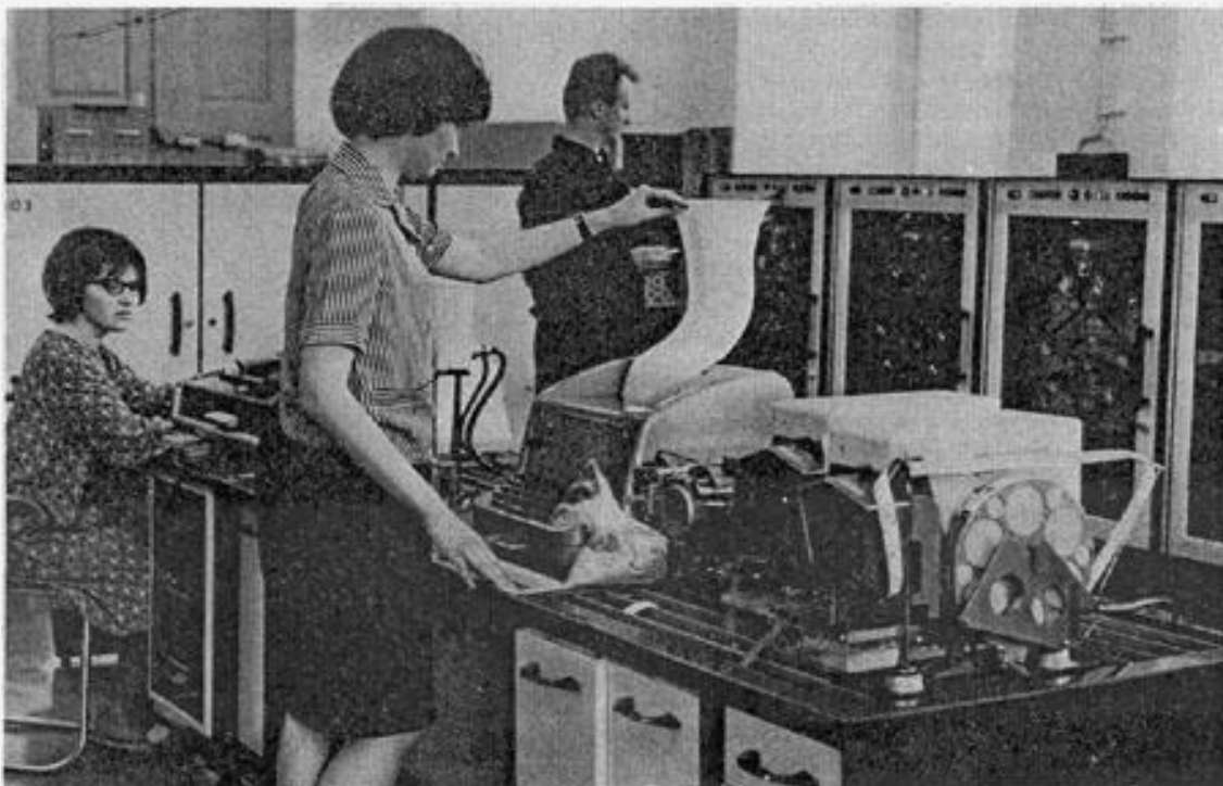
Tranzistorový počítač NE-803 B osazený deseti tisíci tranzistorů a používaný roku 1966 při měření tlakových nádob pro reaktory v plzeňské Škodovce měl operační rychlost 2000 operací/s.
