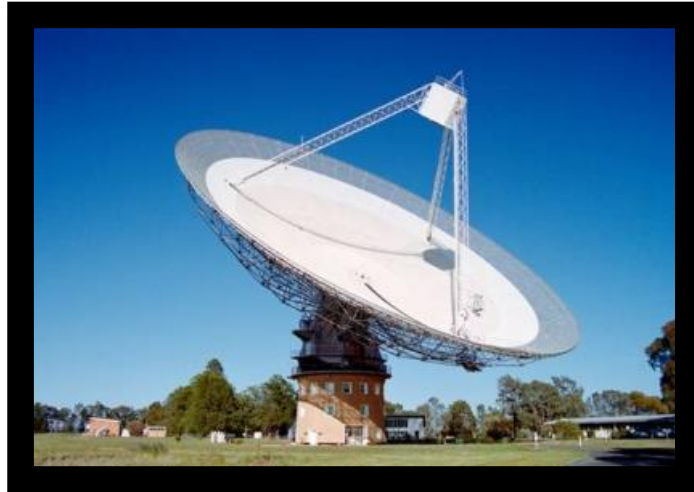
Obrázek 7: Radioteleskop observatoře Parkes (Austrálie), průměr 64 metrů 6
