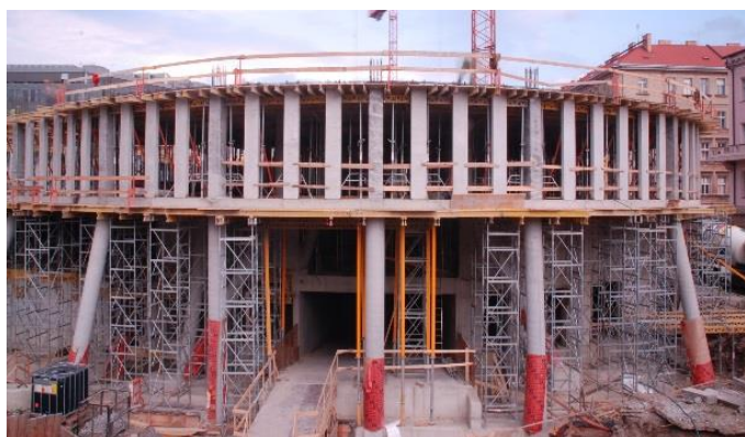
Upravená kompozice – po vytvoření časoběrného záběru požadované délky došlo ke korekci svislic a úpravě na formát budoucího videa 16:9
