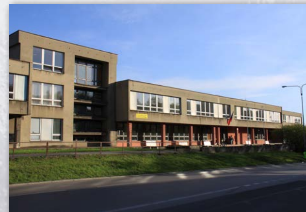
| Objekt bývalé ZŠ na ulici Žižkova
