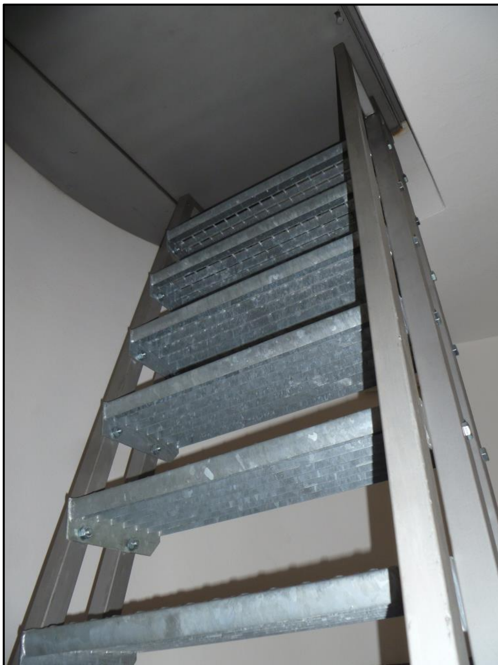
Obrázek 4: Žebřík vedoucí do prostoru pozorovací kopule s dalekohledem.
